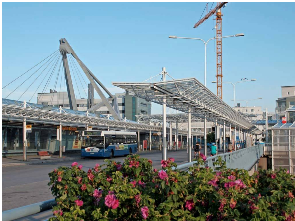
Kuva 33. Mahdollisuuksia siltaterminaalien ja Hämeenkadun joukkoliikennekadun kevyiden katosten rakentamiseksi. Kuva Vuosaaren metroaseman terminaalista Helsingistä.
